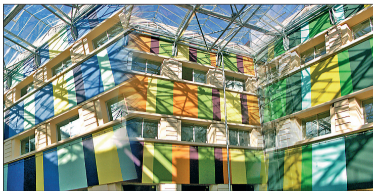
Edificio donde se encuentran las instalaciones de IFR GROUP e IFR Software Factory for Microsoft Dynamics en el Parque Científico y Tecnológico de la ciudad de Lleida. En la primera planta se encuentran los 1500m 2 de instalaciones de IFR GROUP
